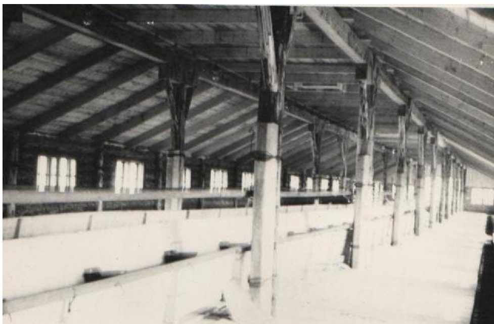
Строительство нового коровника на 400 скотомест, фото 1975
